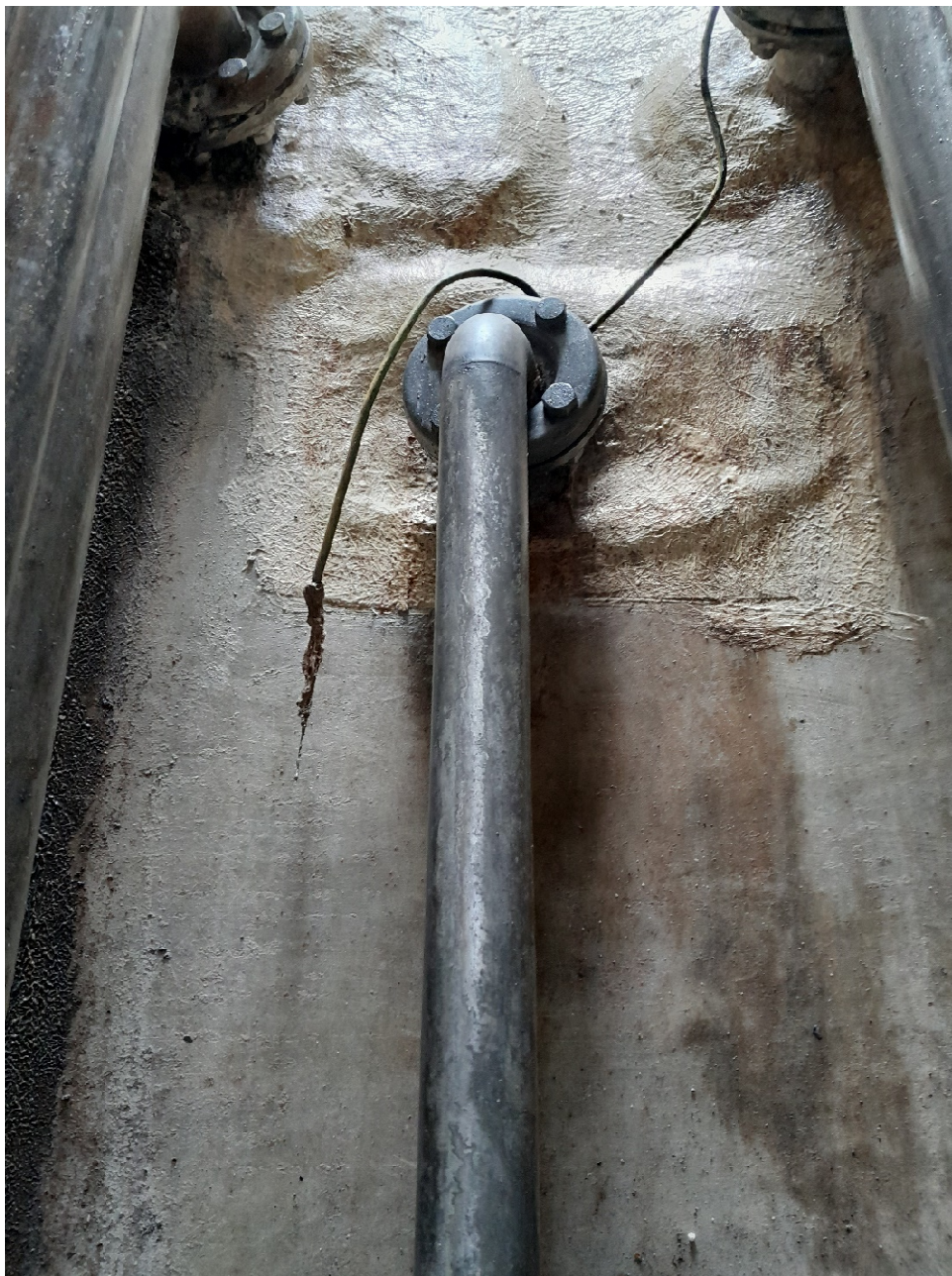
Komora przepompowni -rurociąg zrzutowy zładu
